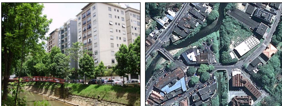
Figura 2.6 – Densa ocupação urbana ao longo do rio Quitandinha (à esquerda) e vista superior da confluência do rio Itamarati com o rio Piabanha (à direita) (Fonte: banco de imagens do Google Earth®).
